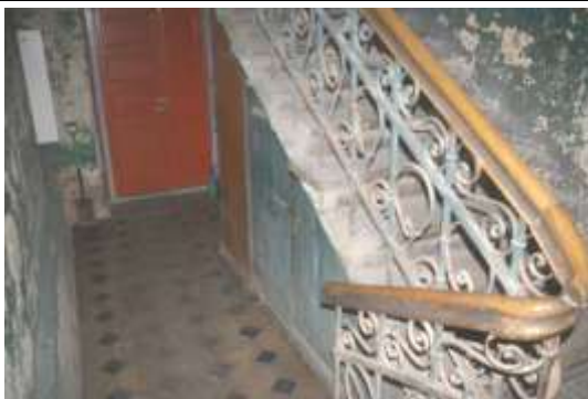
Būve ar kadastra apzīmējumu 6492 006 4257 001, koplietošanas telpa
